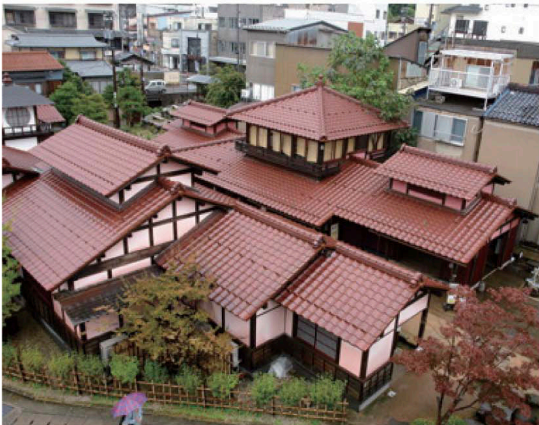
目を惹く赤瓦の大屋根に載る小さな屋根は、「越屋根」といい、本来は煙を出すために作られたものです。3棟の設計は、地元の小島環境設計、バルテノン設計、北陸設計。外構は瀬戸設計事務所、全体を内藤彦建築設計事務所が監修。
