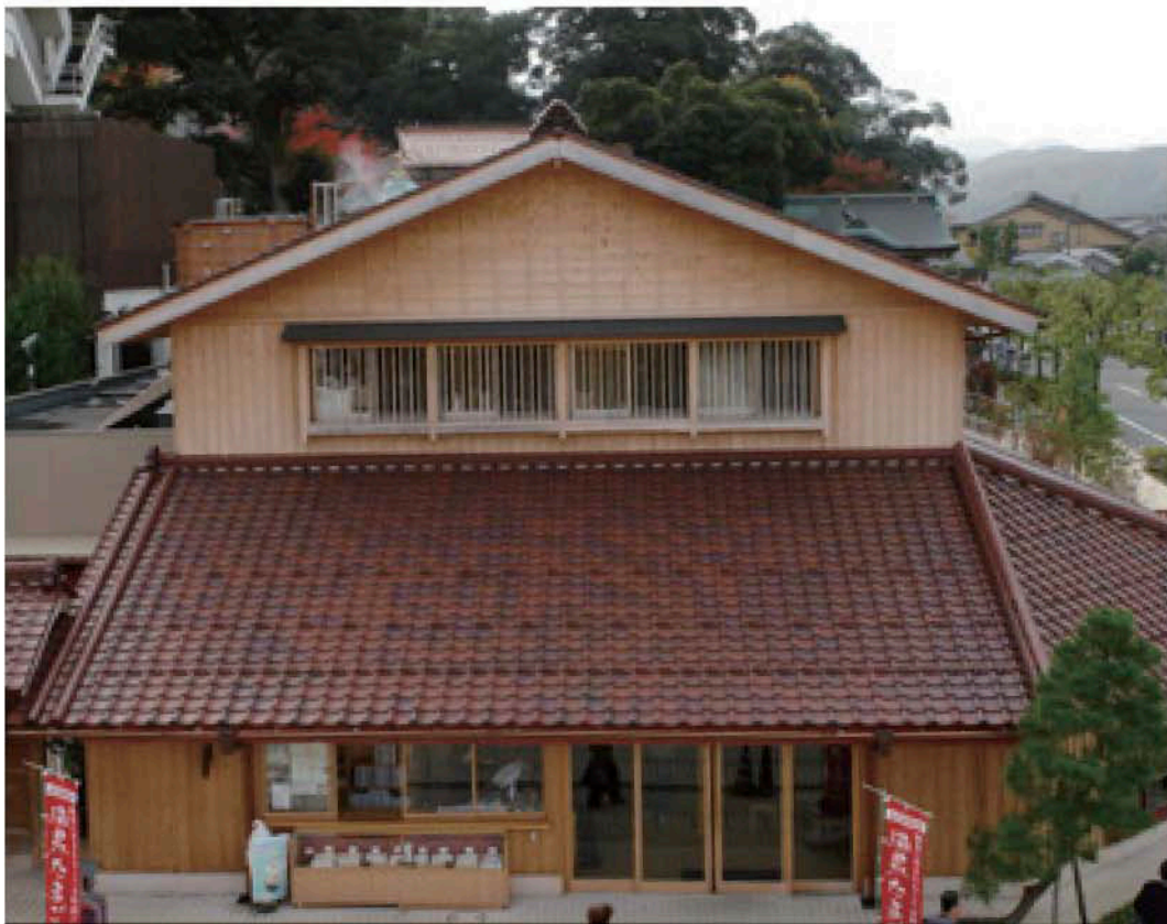
大屋根と下屋は、加賀地方の赤瓦を葺き、外壁は地場産杉を使用した縦羽目板目板張りで仕上げています。古総湯の脇役としながらも凛と佇む姿が印象的です。設計は内藤廣建築設計事務所。
