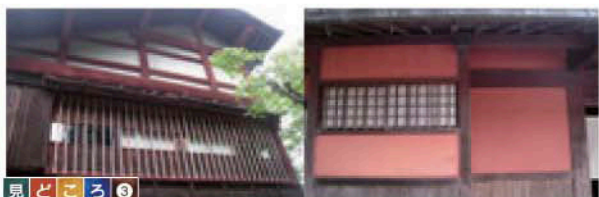
見どころ③ 【紅殻塗り・竹格子】真壁造りの梁や柱、壁に紅殻塗りを施し、窓や戸の格子に竹を使い、雅味のある表情を醸し出しています。
